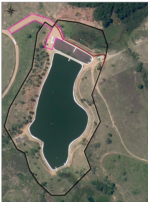
Figura 5 - Visualização do acesso e calçada na ETE Nova Rosa da Penha
